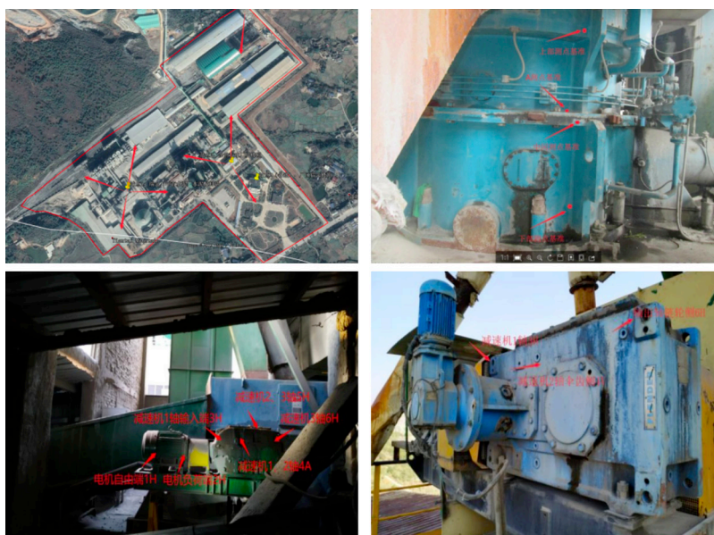
图 20：安装在线监测系统
