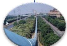
原料运输皮带无人化监控
